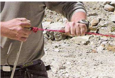
10 Aus sicherer Distanz wird mit der Abzugschnur die Spaltung ausgelöst.
