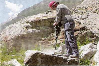
1 Das Loch wird hier mit einem \varnothing von 28 - 45 mm gebohrt.
